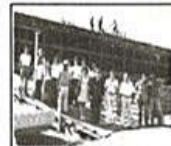
Construção do Prédio - 1977
