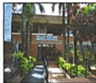
Fachada do Prédio
